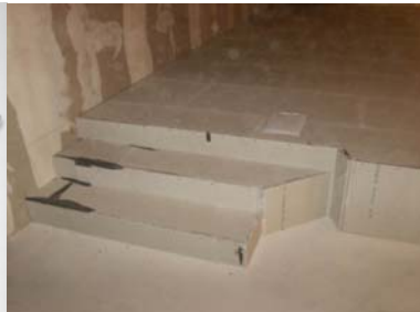
Hohlboden mit Treppe und Verkleidung
